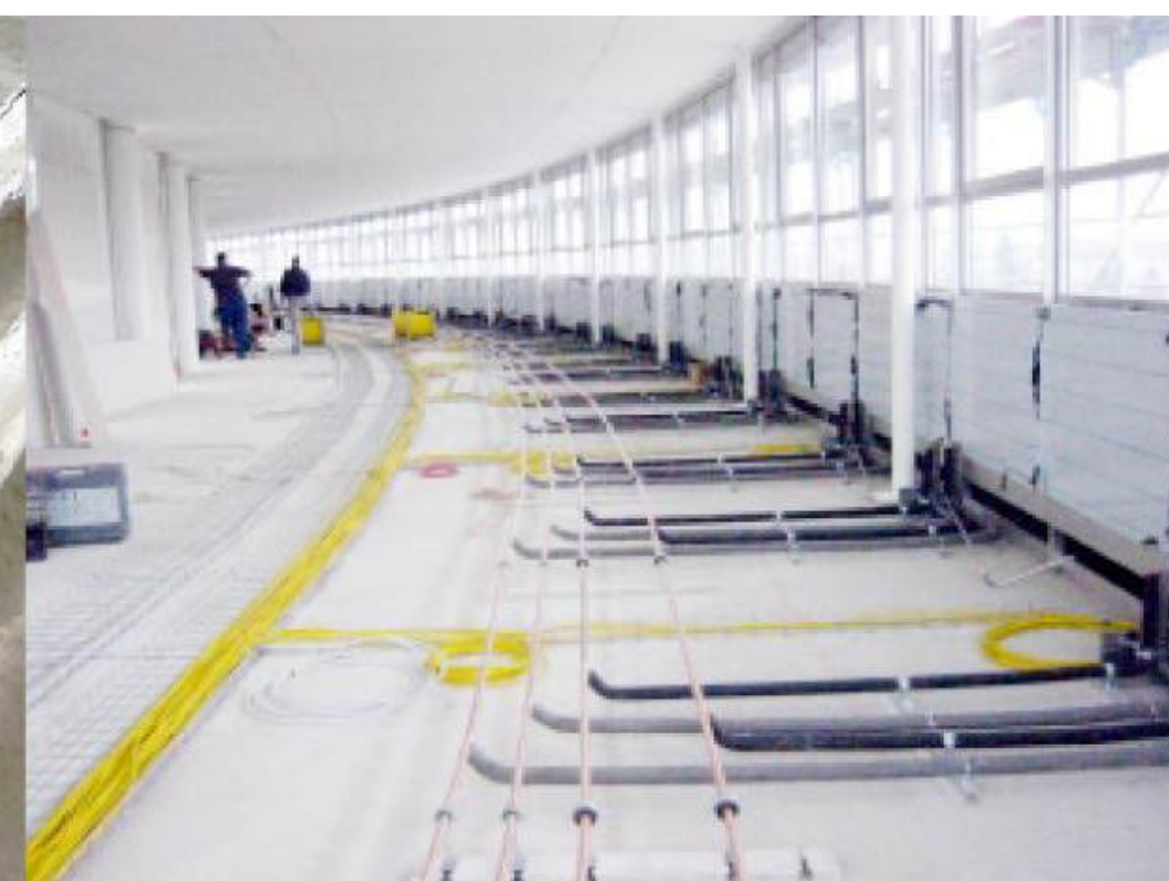
bauen wie geplant
