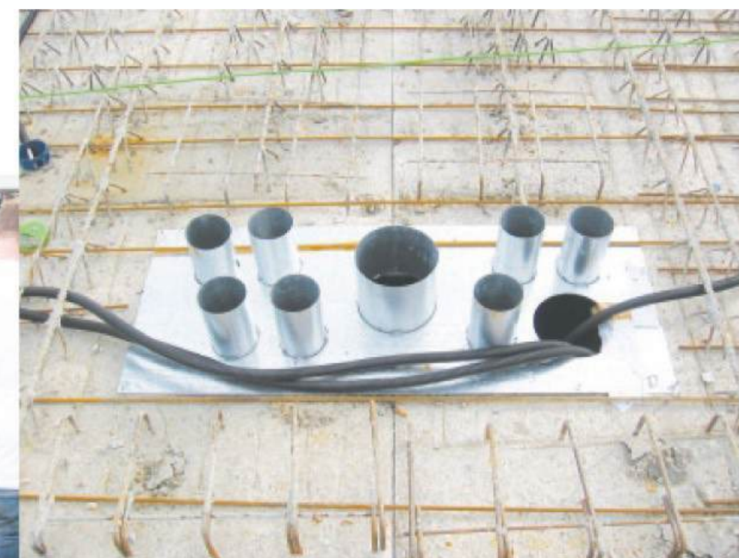
einbau auf filigrandecke
